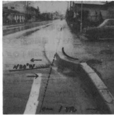
写真4 地盤変動により道路が約1年で約1mずれた
