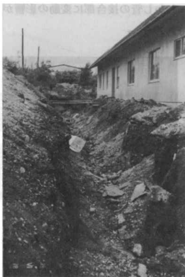
写真7 山側（押す側）に溝を掘削して、地盤変動の影響を少なくしている。これは、地盤変動災害軽減の一策
