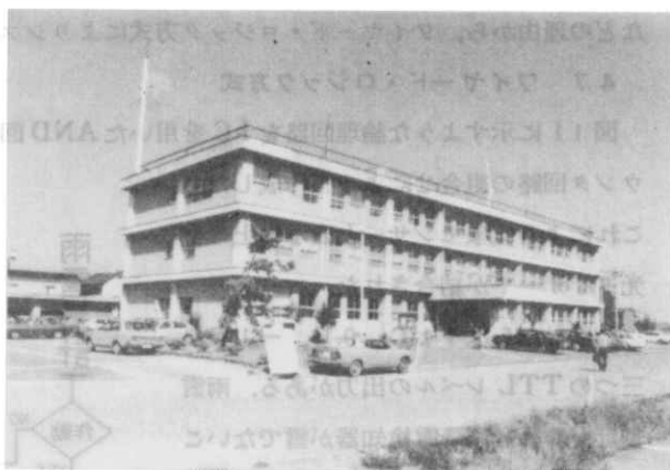
写真4 小千谷土木事務所
