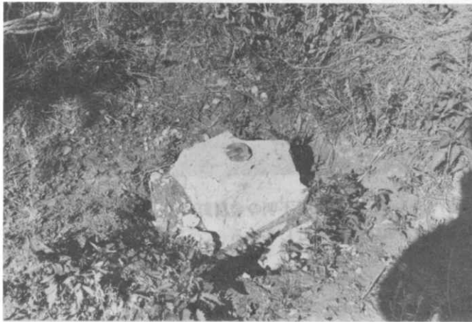
写真3 水準点4 3.9 mは標石の頭部を大破し大きく傾いている
