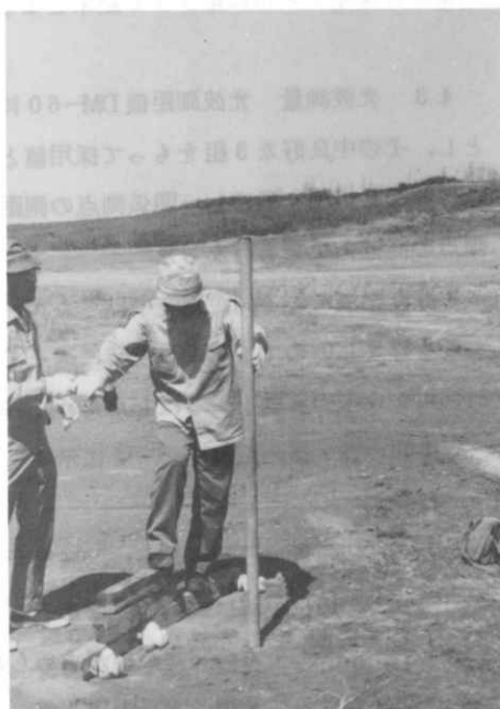
写真5 測点の埋標、鉄管径5cm×2mの打込作業
