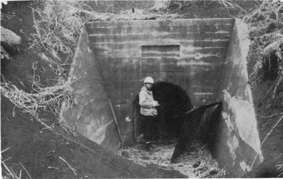
坑道入口。入口から100 mだけコンクリート巻の施工済みであるが、高さが1 m50cmなので歩行しにくい。水は全くない。
