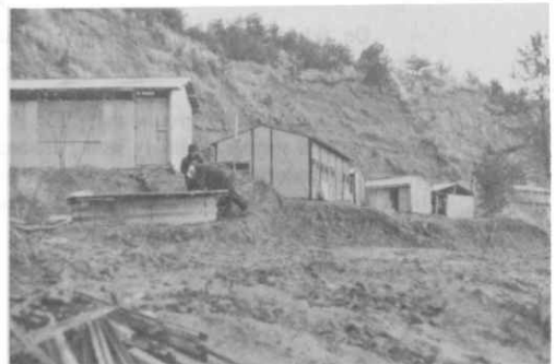
写真-3 松本地区の滑落崖と集水井
