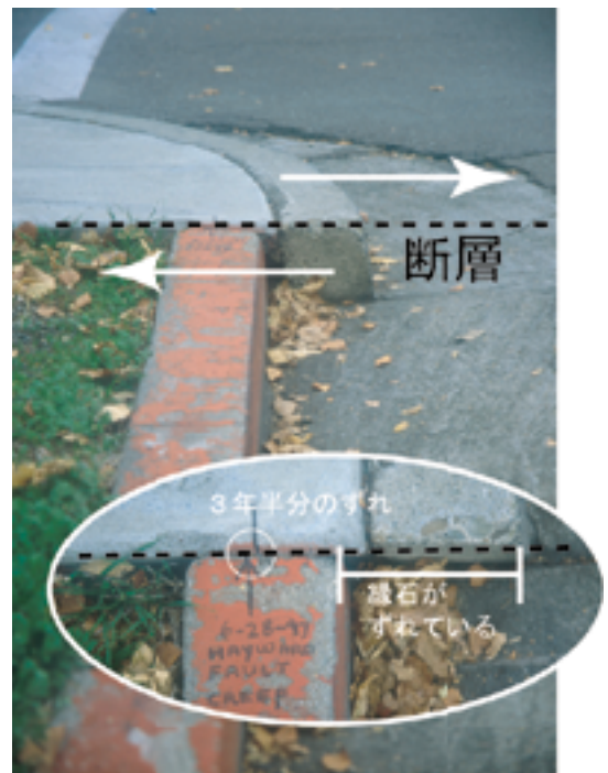
図2 もともとは一直線だった緑石が、クリープにより長年の間に大きくずれてしまった。1997/6/28の緑石の位置が書き込まれており、3年半の間に1cmあまりクリープしたことが分かる。
