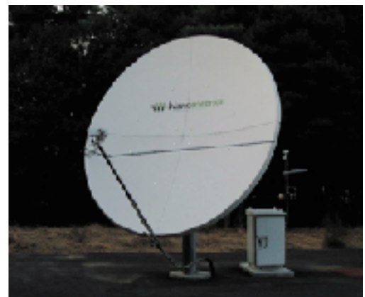
図2 防災科研構内に設置された直径3.8mの パラボラアンテナ
