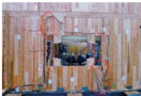
写真2 開口入隅部の破壊 (試験体：B棟)
