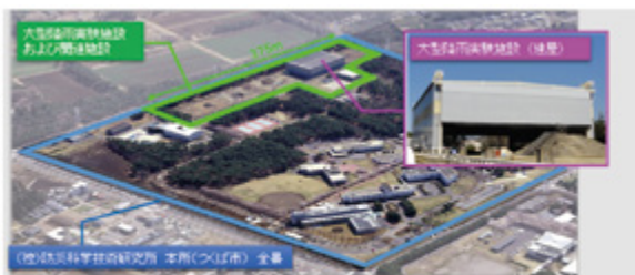
図1 大型降雨実験施設
