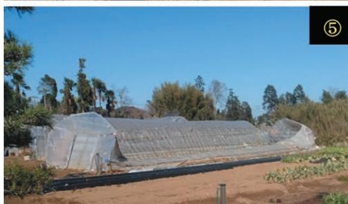
図 4 竜巻による農業施設の被害(①マルチフィルムの剥離、②鉄骨ハウス基礎の浮き上がり、③両屋根型単棟ハウスの倒壊、④、⑤パイプハウスの屈曲、2018 年 3 月 2 日撮影、茨城県行方市)
