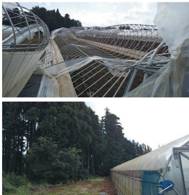
図10 台風1915号により被害を受けたパイプハウス(上、図11のB団地)および、被害のなかったパイプハウス(下、図11のE団地。図11の★の位置より2019年9月20日撮影。千葉県八街市)
