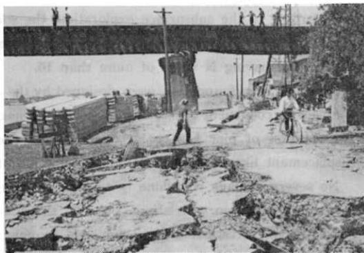
写真—1 越後線信濃川橋梁1号ピアの傾斜
