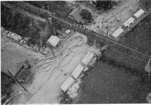
写真-2 信濃川橋梁 1A, 1P 付近川岸の移動と地表面のクラック状況
