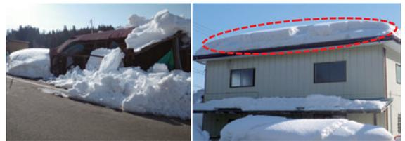
図2 長野県北部地震によって落下した屋根雪（長野県栄村）
