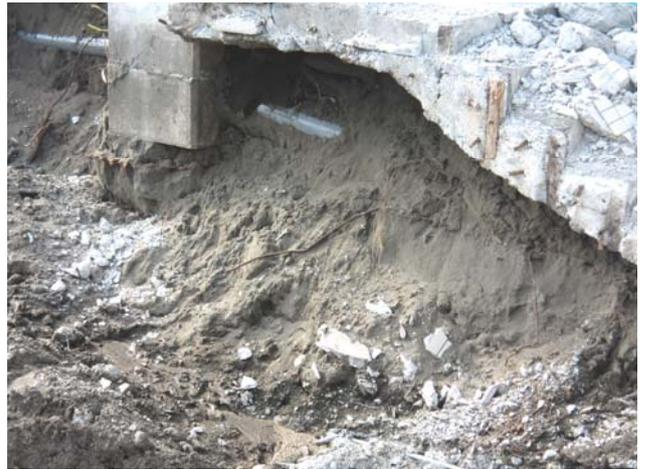
写真3 取り壊し中の住宅の基礎から見えている砂地盤
